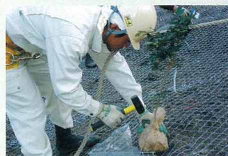
苗木・斜林ベース設置工
