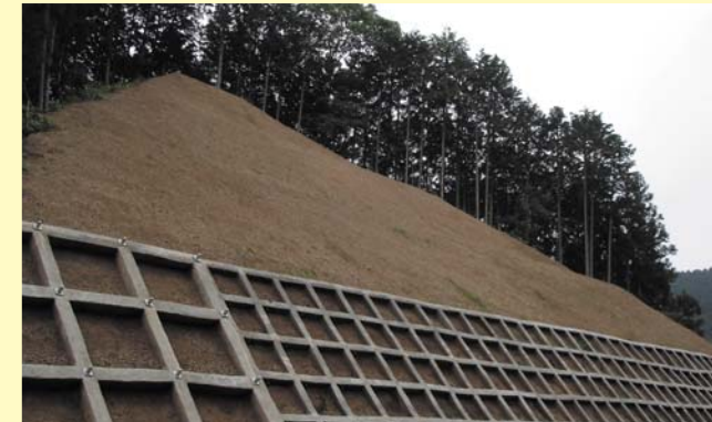
吹付施工直後
