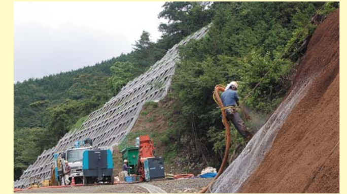
補助材料添加・吹付工
