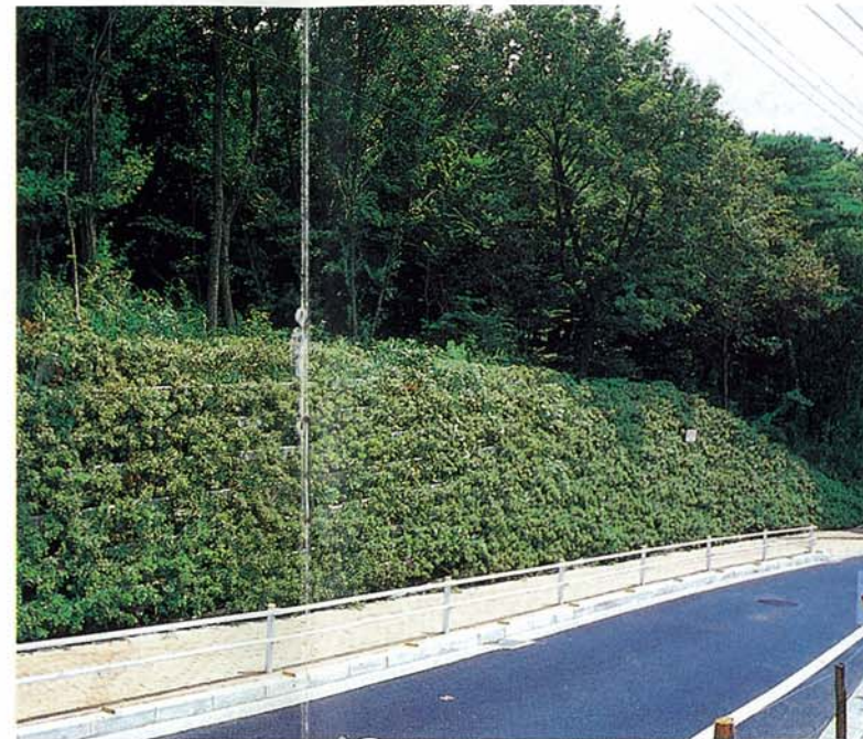
市道整備工事(東京都)
