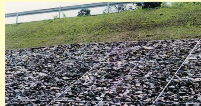
盛土のり面 災害復旧工 H150
