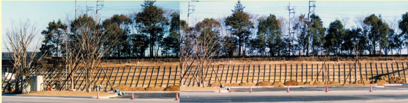
レキ混り粘性土のり面 H100
