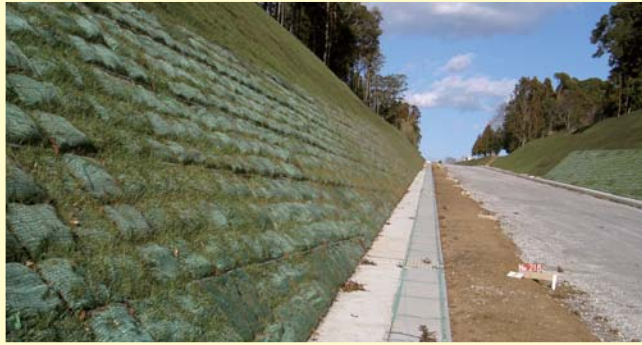
砂質土のり面 植生土のう工 H100
