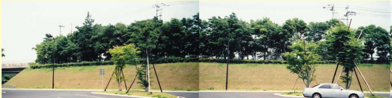
レキ混り粘性土のり面 客土・全面高らい芝張工 H100
