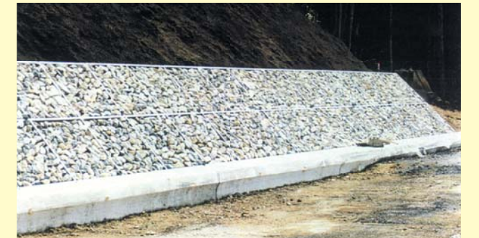
湧水切土のり面 栗石詰工 H150
