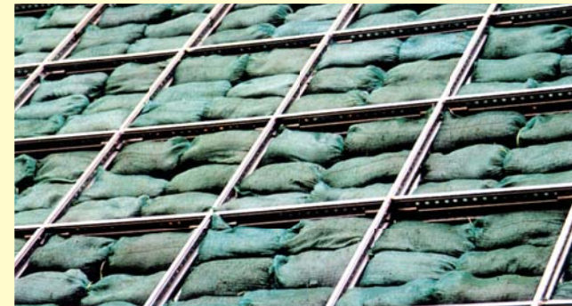
切土のり面 植生土のう工 H100
