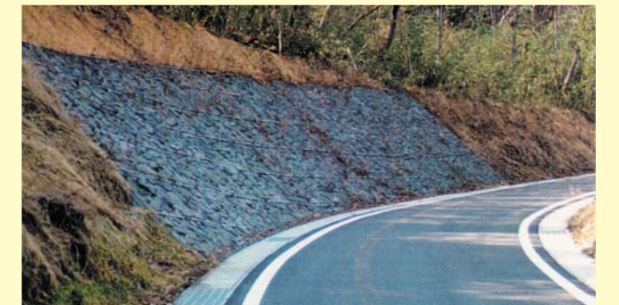
湧水切土のり面 栗石詰工 H150
