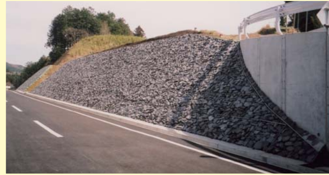
湧水切土のり面 栗石詰工 H150
