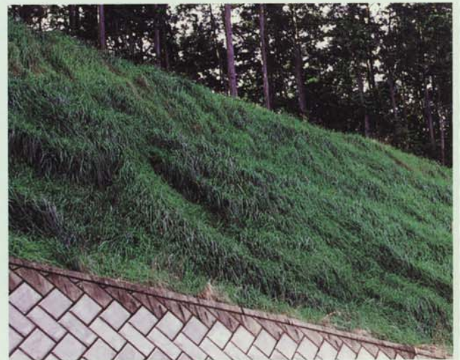
農道整備工事
