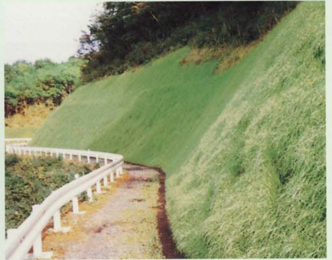
林道改良工事
