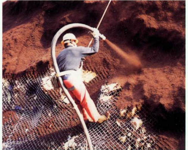
グリーンロック吹付工
