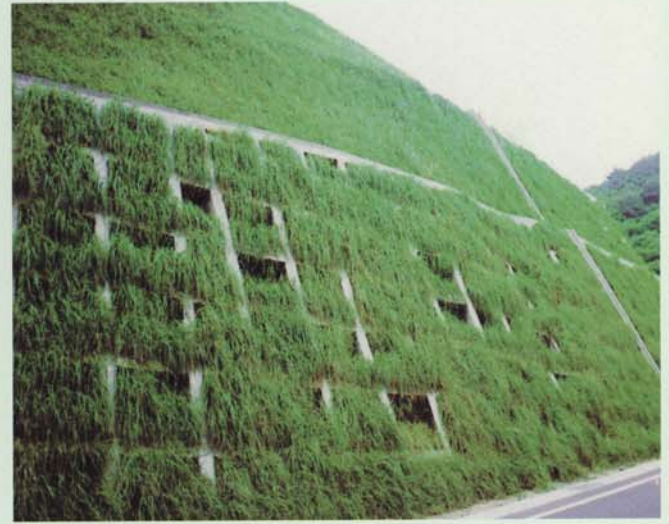
国道改良工事：吹付のり枠併用工
