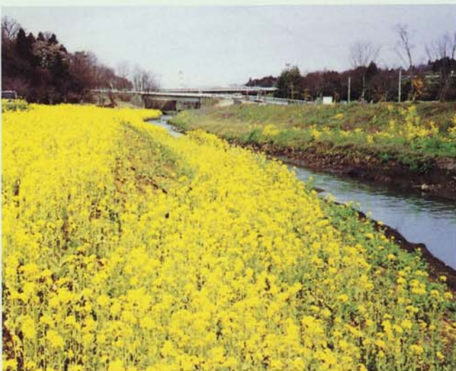
河川改良工事：草花種子
