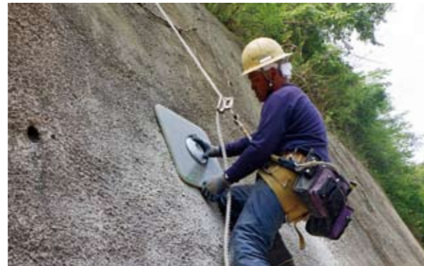
頭部固定工 (フラットプレート取付工)
