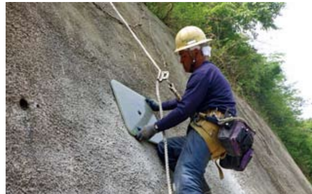
GS20 受圧板の設置
