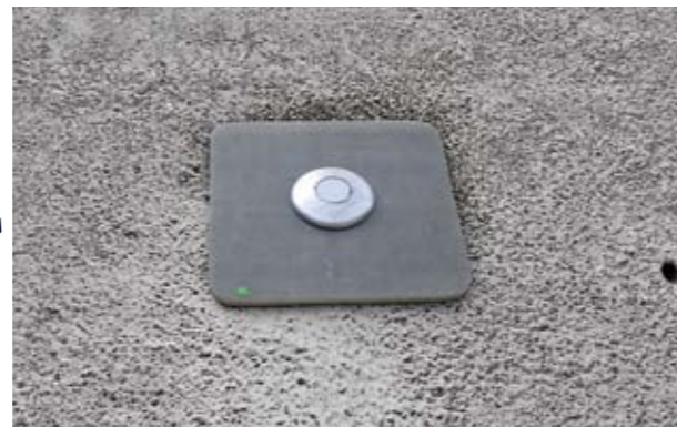
フラットキャップによる頭部処理
